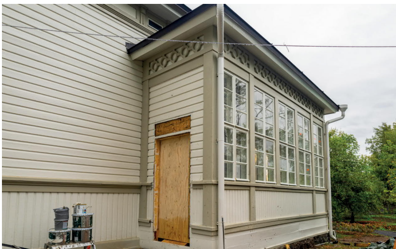
Perusparannushankkeen alussa tehdystä väritutkimuksesta julkisivusta paljastui kahdeksan eri maalikerrosta. Nyt talo puutetaan alkuperäiseen valkoiseen väriinsä.
